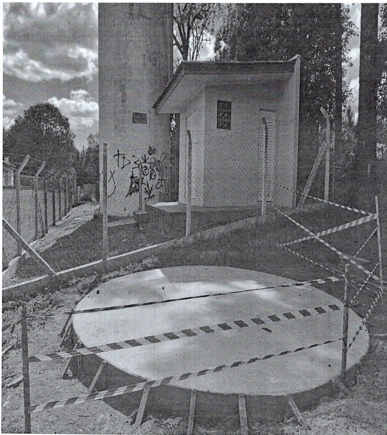
Base para a nova Caixa de água
