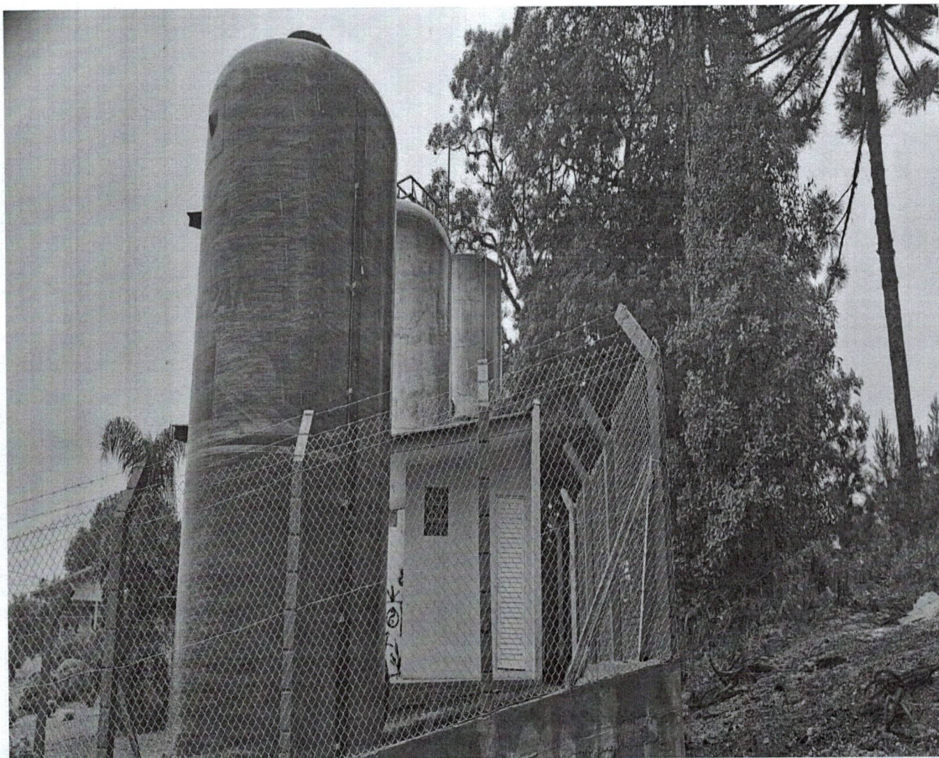
Ao fundo a nova caixa instalada
